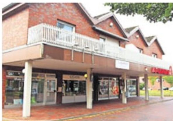
Das alte Gebäude mit der Delm-Apotheke bleibt noch stehen, bis links daneben der Neubau fertig ist.
